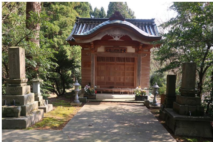
<写真 1>大屋共同納骨堂 (石川県珠洲市)
